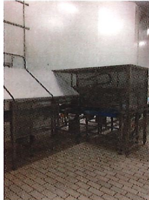
Installation des carters de protection sur G2 ligne Mécatherm L4/L2
